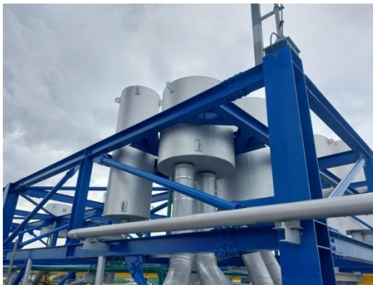
รูปที่ 3-48 อุปกรณ์ลดเสียง (Silencer) ขณะทดสอบเครื่องจักร (Commissioning)
