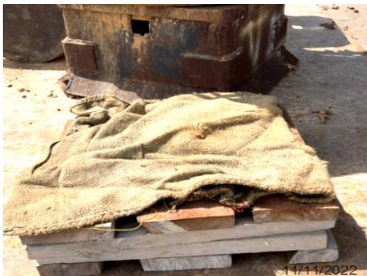
รูปที่ 3-14 ไม้หมอนและกระสอบรองหัวเสาเข็ม
